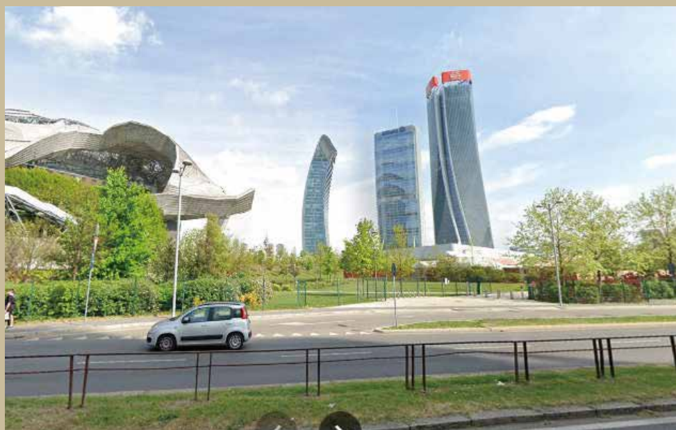
ミラノの再開発 シティー・リフェ地区（商業・業務複合開発） イタリアには少ない高層ビル地区
