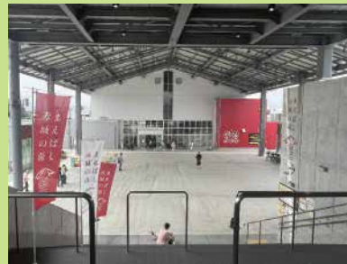
■ 屋根付きの多目的広場
