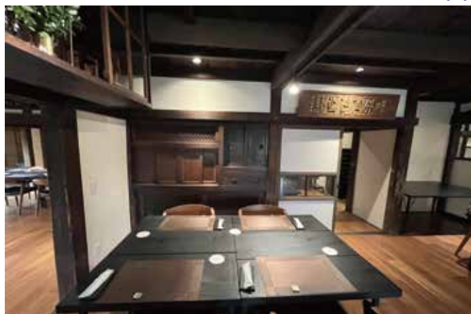
■ Befor 写真と同様の角度から見た広間1。神棚と仏壇部分を残し、新たに設置した壁で耐震性を確保しています。
