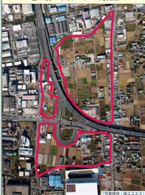
着工前：令和3年11月撮影
