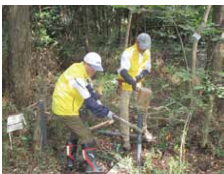
■ ロープ柵補修作業
