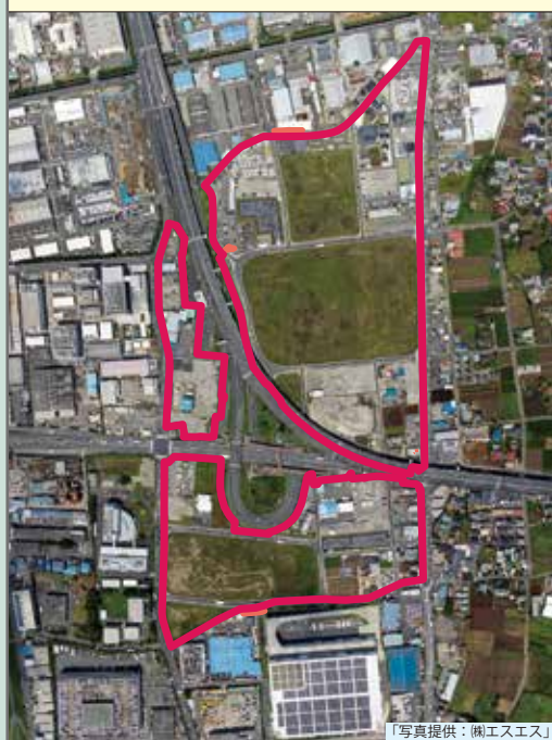
施工中：令和6年8月出来高99.9%
