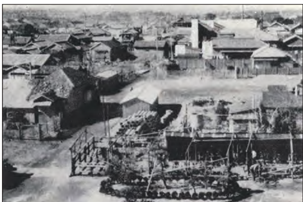
■ 施行前の旧市役所前通りの様子
