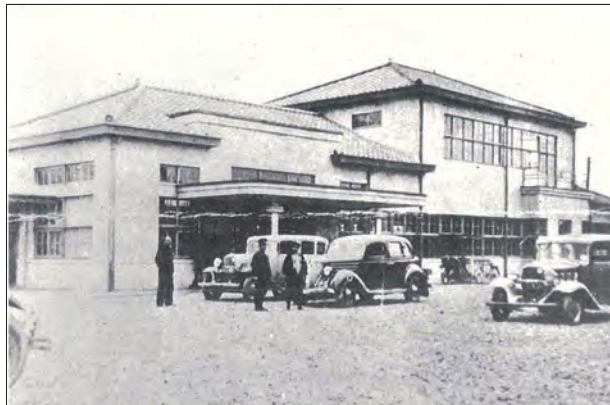
■ 施行前の銚子駅と駅前広場の様子
