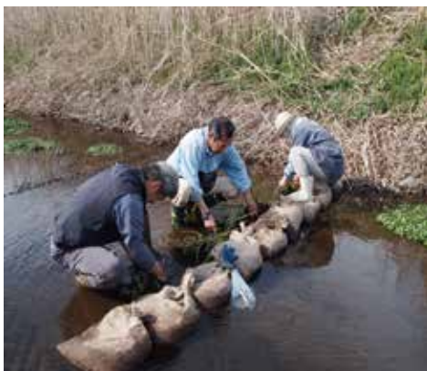
工事場所の生き物の救出や、工事後の拡幅された川に土嚢を並べ、マコモを植え付け川の再生に取り組みました。
