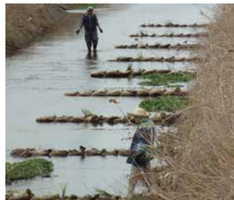
工事場所の生き物の救出や、工事後の拡幅された川に土嚢を並べ、マコモを植え付け川の再生に取り組みました。
