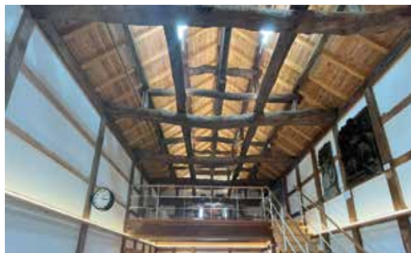
■ 太く立派な梁が活かされた空間
