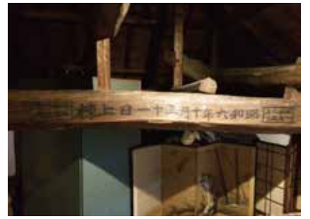
■「昭和六年十月三十一日上棟」の文字が刻まれた立派な梁
