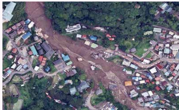
熱海市で発生した土石流災害 「出典：国土地理院撮影の空中写真(2021年撮影)」
