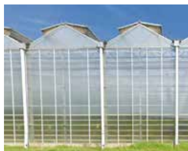
高性能なフェンロー温室
