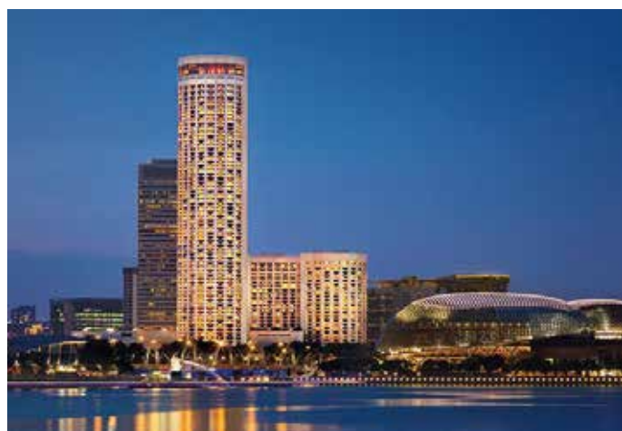
■ ラッフルズ・シティ・コンベンションセンターとエスプラネード・シアター
